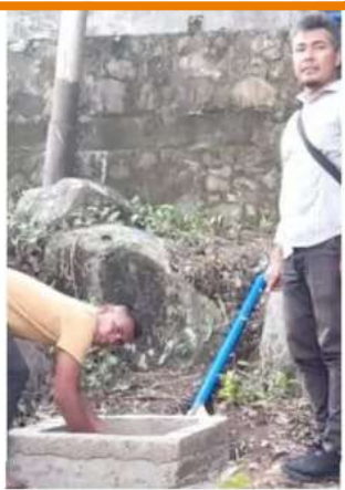
UJI COBA: Dinas Pekerjaan Umum dan Perumahan Rakyat (PUPR) Kota Sabang bersama PDAM Tirta Aneuk Laot melakukan uji coba instalasi pipa air bersih di Pulau Rubiah, Boih, Kota Sabang, Minggu (21/1/2024).
